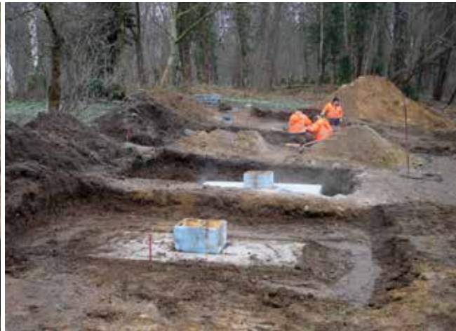
Vier tragfähige Betonfundamente
