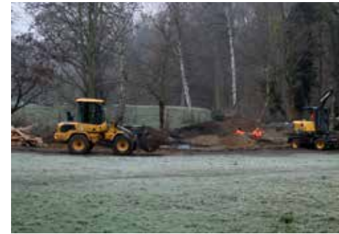
Für die Baustellenfahrzeuge ein Weg mit Stahlplatten
